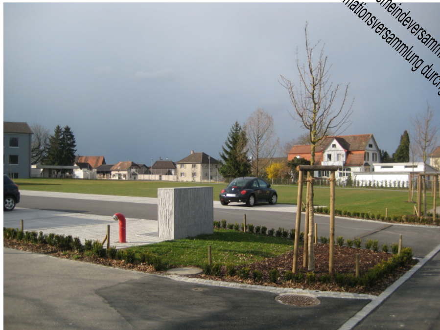
Neue Parkplätze und Schotterrasen
