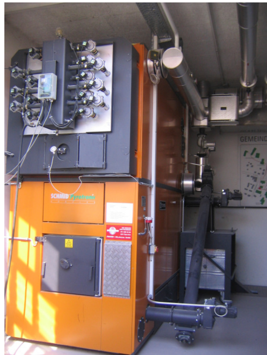
Heizung Holzsnitzelanlage
